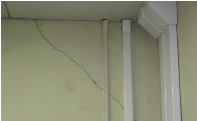
図8:壁のひび割れ（クラック）
