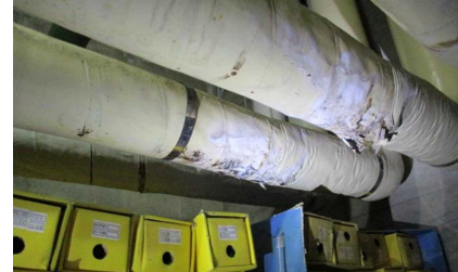
図10:配管の老朽化
