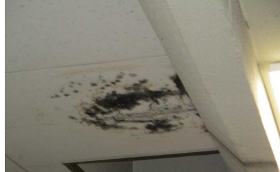
図9:天井からの雨漏り
