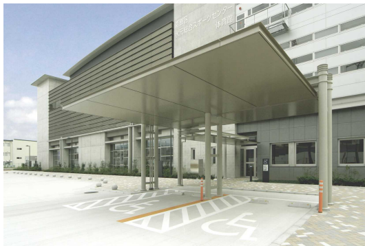
図 29：屋根付駐車場とアプローチ（葛飾区）
