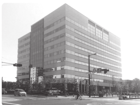
守口市役所新庁舎 （元三洋電機本社）
