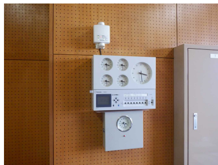
[写真2] 西中 プログラムタイマー交換
