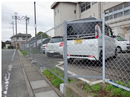
[写真1] 西小 ブロック塀改修
