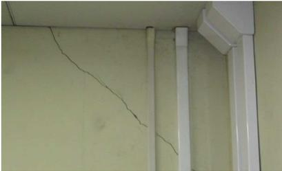
図 8:壁のひび割れ（クラック）
