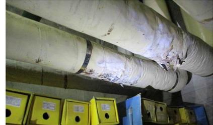
図 10:配管の老朽化
