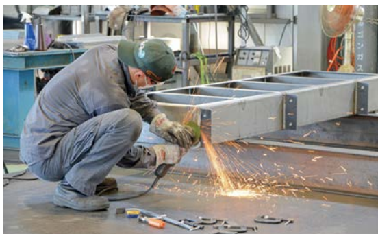
■暑さに負けず、大量に汗をかきながらの溶接作業
