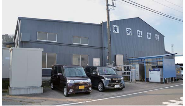
▲事務所のある工場の外観
