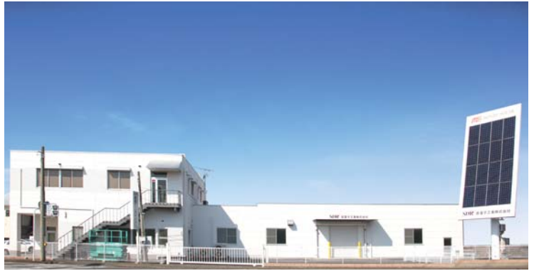
▲本社には大きな太陽光発電パネルを設置しています
