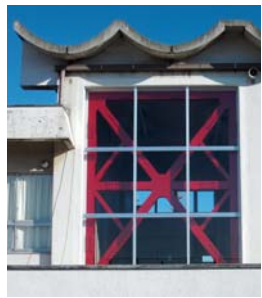
耐震補強された窓
