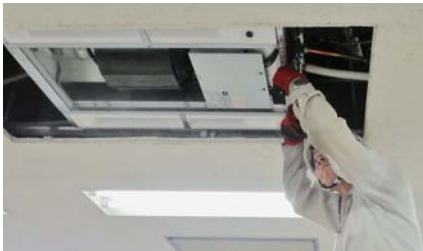
▲空調設備の工事の様子
