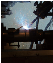
▲機械で行う溶接
