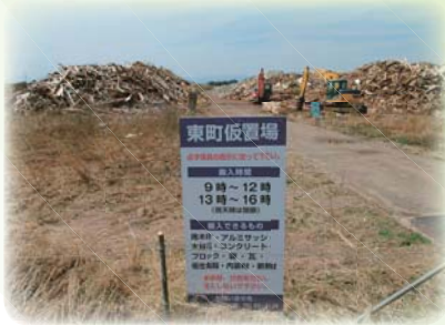
がれきの仮置場
