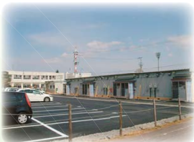
旭町応急仮設住宅
