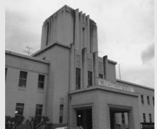
福島県郡山合同庁舎
