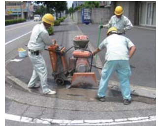
バリアフリー化工事の様子
