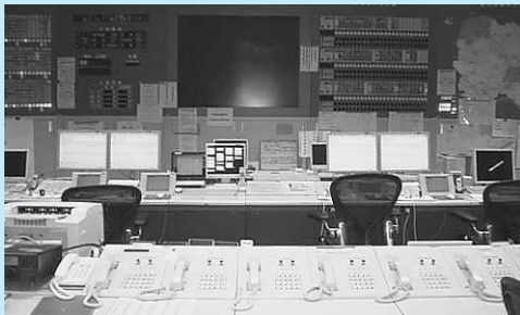
太田市消防本部通信司令室の様子
