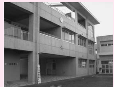
完成した新校舎
