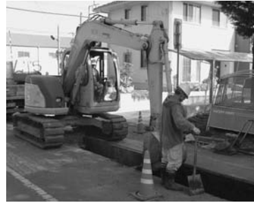
下水道工事を進めています
