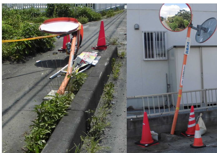
【交通事故により破損した道路反射鏡】
