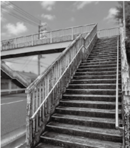
維持管理を継続する歩道橋
