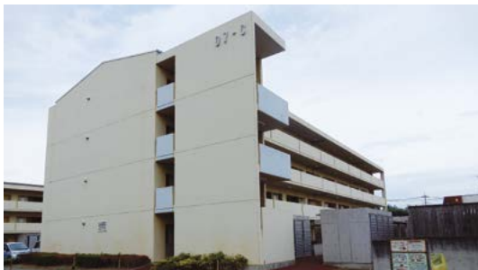
吉田北町営住宅団地
