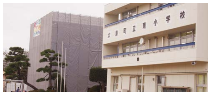
改修工事中の南小学校
