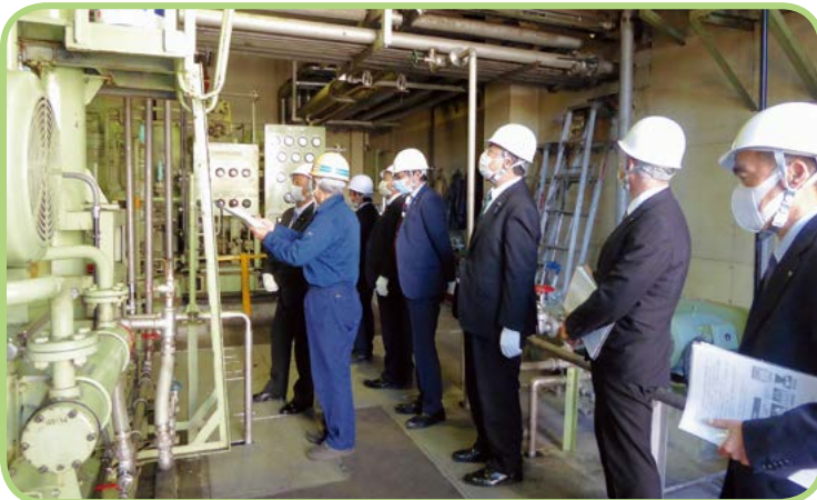
衛生センターの現地調査の様子
