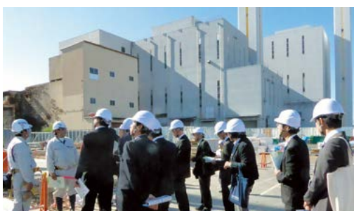
建設中の新ごみ焼却施設
