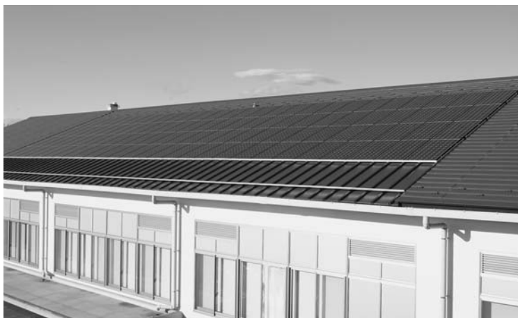
ソーラシステムを導入した町施設
