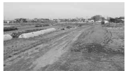
市街化区域内の未舗装の町道(寄木戸)
